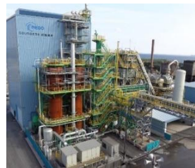
12m 3 小規模試験高炉(水素還元)
