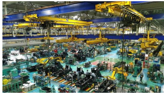
建設機械組立工場 (2014年5月30日竣工)
