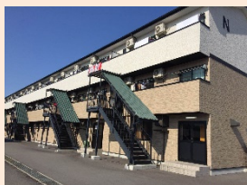
新設した外国人専用の寮（外観）
