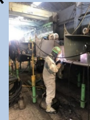
溶接作業の様子
