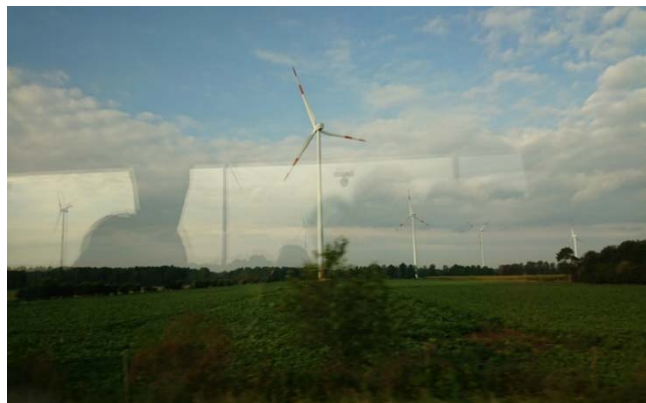
アウトバーン沿いの風力発電機
